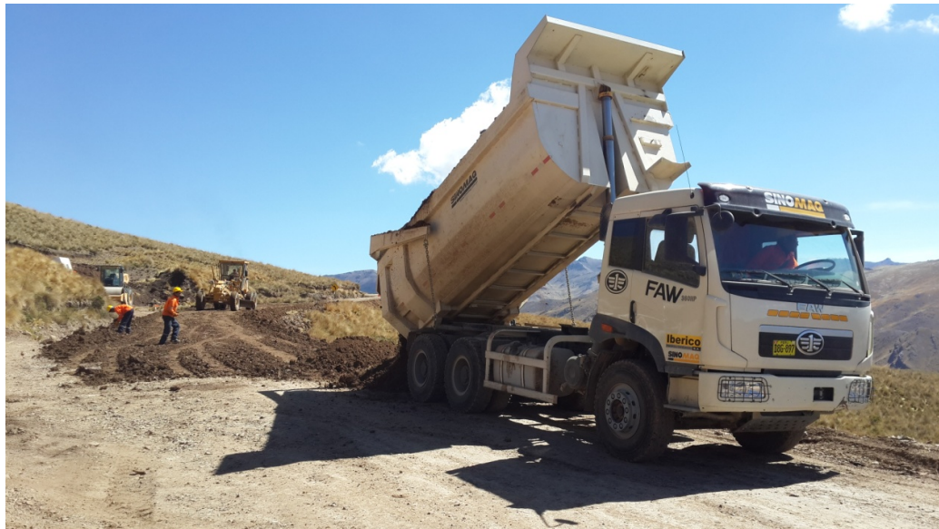
Vista N°2: Transporte y colocación de material de afirmado
