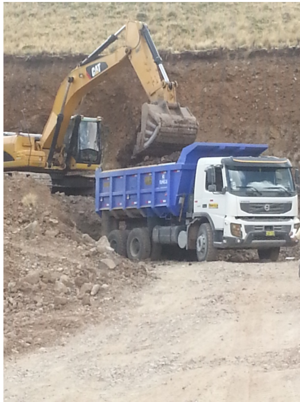
Vista N°1: carguío de material afirmado en cantera
