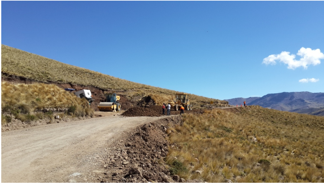
Vista N°3: Conformación de la capa de afirmado
