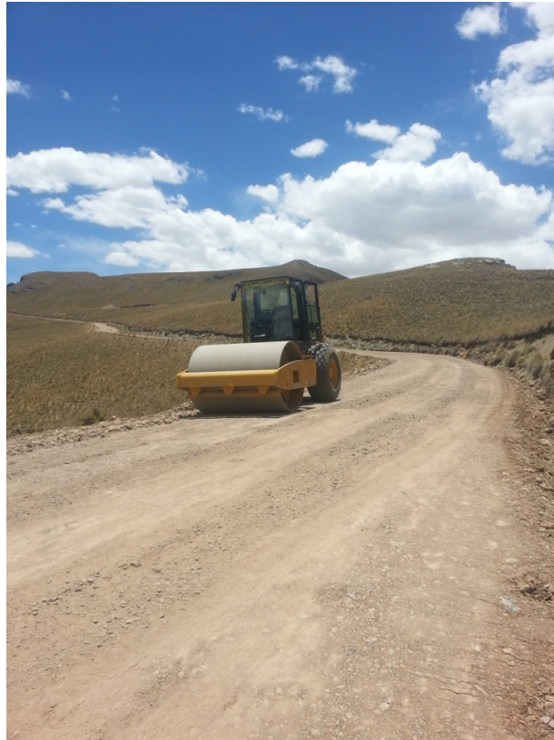
Vista N°4: Compactación de capa de afirmado
